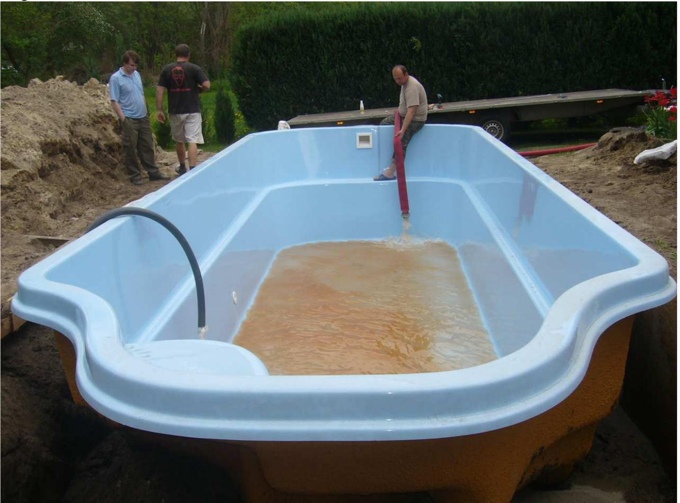
6. Man bestreut die Beckenseiten mit dem Sand-Zement-Mörtel bis zum Ausgleich der Stände des Mörtels und des Wassers.
